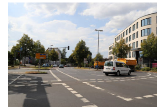
Abb.5 autogerecht ausgebaute Verkehrsinfrastrukturen, z.B. Kreuzung Bardostraße-Frankfurter Straße
