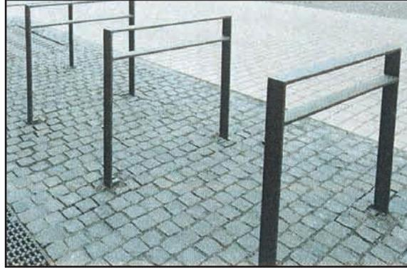
Fahrradbügel Flachstahl 80 x 12 mm (mind. 1,00 m Breite)
