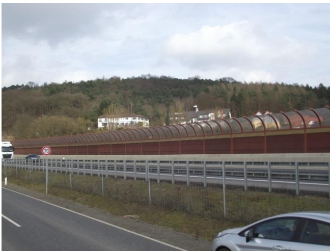
Abb. 5: Abbildung einer gekrümmten Lärmschutzwand
