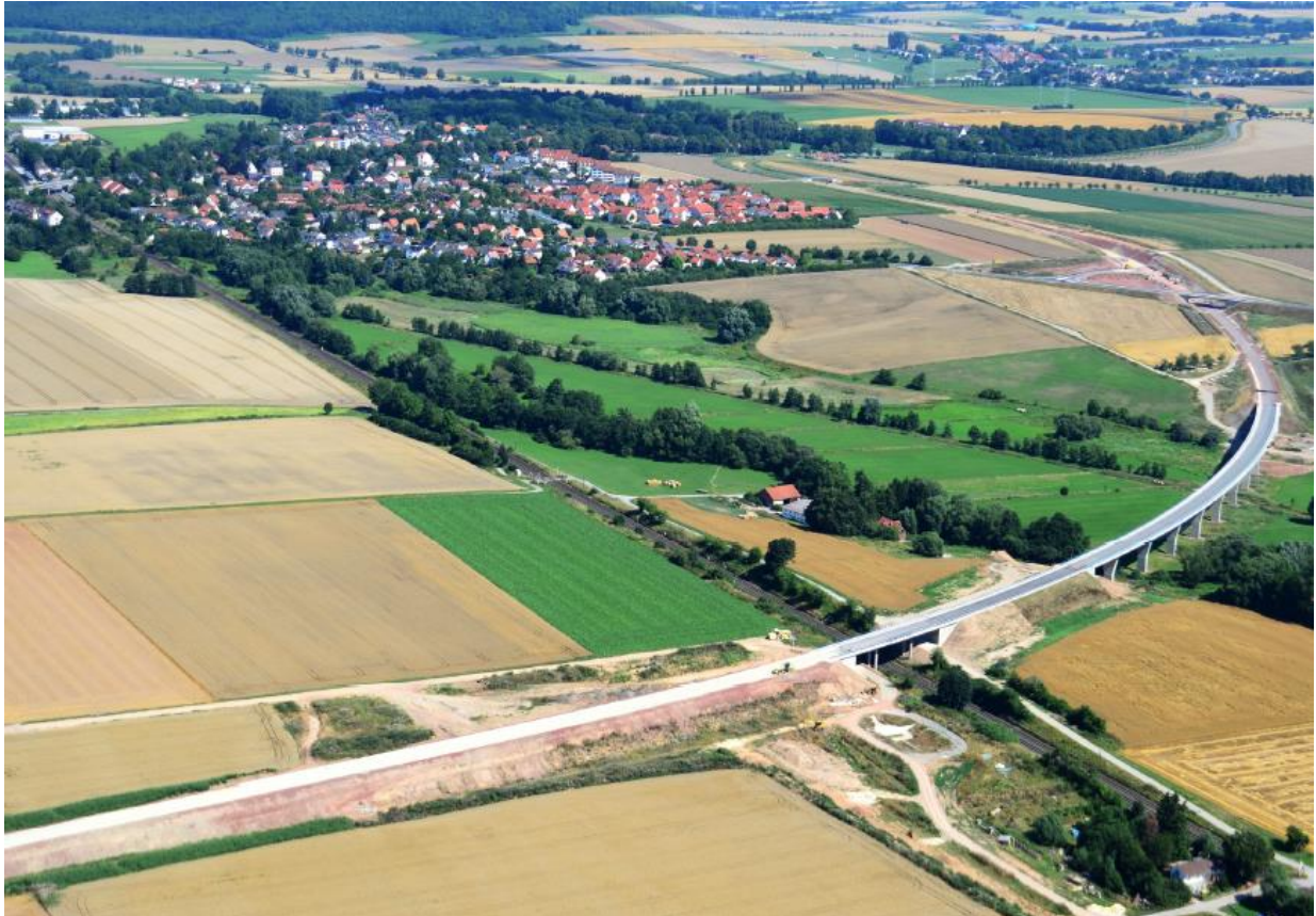
Abbildung 64: Hofgeismar – B 84 – Ortsumgehung [Quelle: Hessen Mobil]
